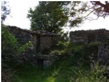
Casolare di S. Lorenzo B. - Foto C. Faillace
